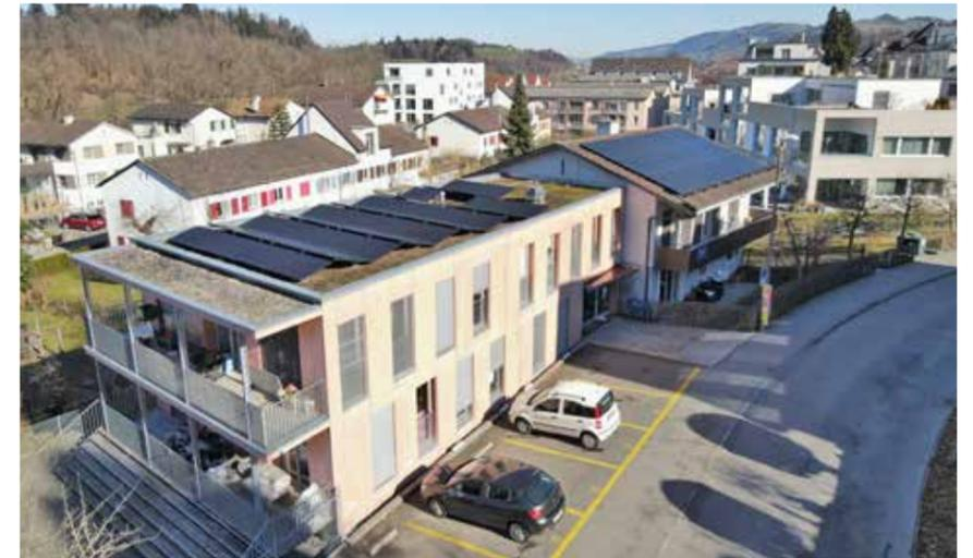
Mit einer Modulfläche von rund 125 m<sup>2</sup> erreicht die Photovoltaik-Anlage eine Leistung von 24.8 Kilowatt Peak und produziert rund 22'000 kWh Solarstrom im Jahr. Die 68 Module sind auf dem Flachdach des Neubaus und dem Schrägdach des angrenzenden Gebäudes montiert.
