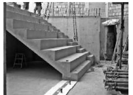
Beim Erweiterungsbau auf der Nordseite wurden zuerst die Stufen der neuen Aula eingebaut. Dieser Bauabschnitt verläuft plangemäss und schon bald kann der Rohbau abgeschlossen werden.
