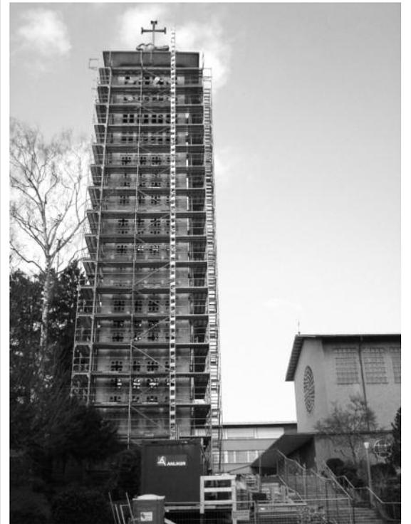
Der Turm der Maihofkirche muss saniert werden. Nach mehr als 50 Jahren ist sein Betonskelett vom vielen eindringenden Regen beschädigt. Nach einer gründlichen Renovation wird er wieder aussehen, wie ihn Architekt Otto Dreyer ursprünglich geplant und gebaut hat.
